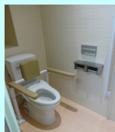
浴室トイレ改修
