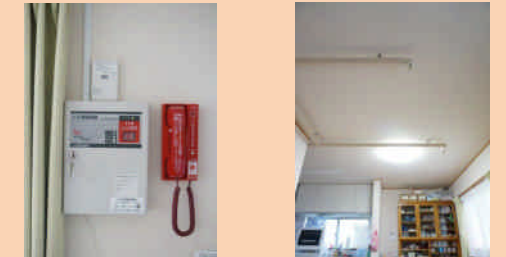
自動火災報知設備 スプリンクラー整備
