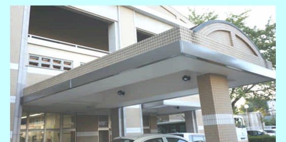
玄関先庇先端部修繕
