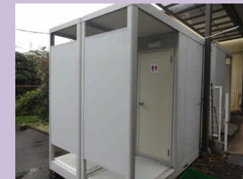
屋外トイレ改修
